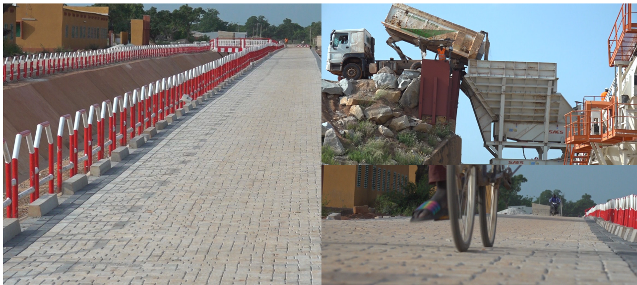
Assainissement et pose de pavées à Fada
