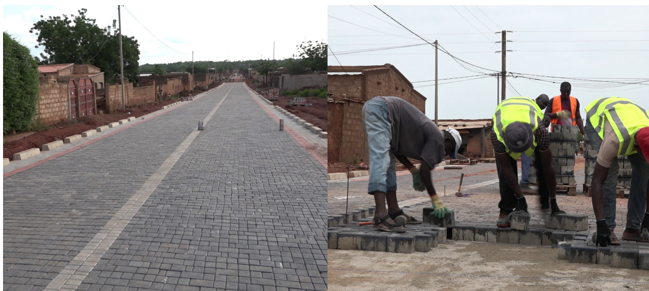
Assainissement et pose de pavées à Tougan
