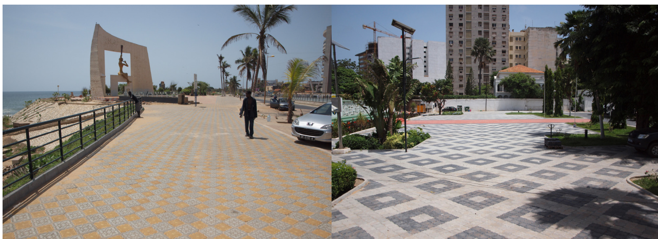
Pose de pavée dans la ville de Dakar au Sénégal
