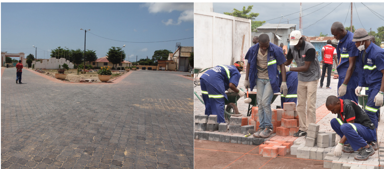
Assainissement et pose de pavées dans la ville de Brazzaville, Congo
