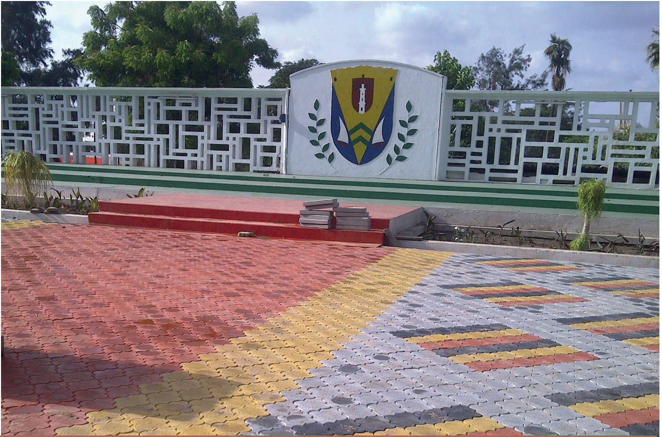
Assainissement et pose de Pavés à la mairie de Dakar
