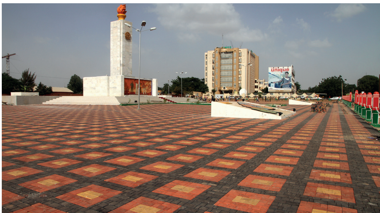
Assainissement et pose de Pavés à la Place de la Nation
