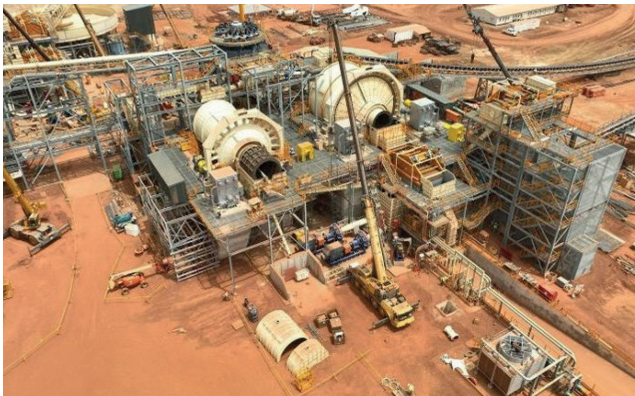
La construction de la mine de Kiaka est très avancée et progresse dans le respect des délais et du budget
